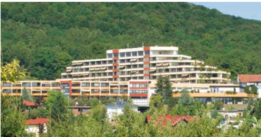
Parkwohnstift u. a. Fassaden, Heizsystem, Küche, Foyer Kosten: 6,7 Mio. Euro
