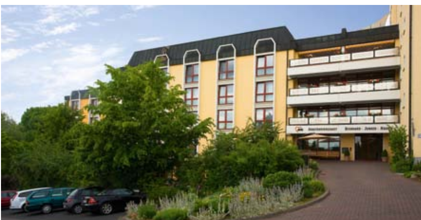
Bernhard-Junker-Haus Generalsanierung des Altbaus von 2005 bis 2009 Kosten: 4 Mio. Euro
